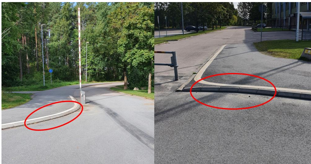
Figur 6 Kantsten som kan sänkas i anslutning till bom och bilspärr.
