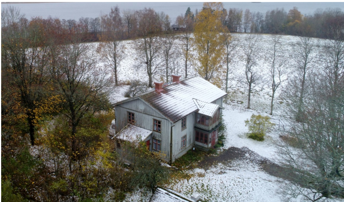
Huvudbyggnaden på Äspenäs gård sedd från öster.
